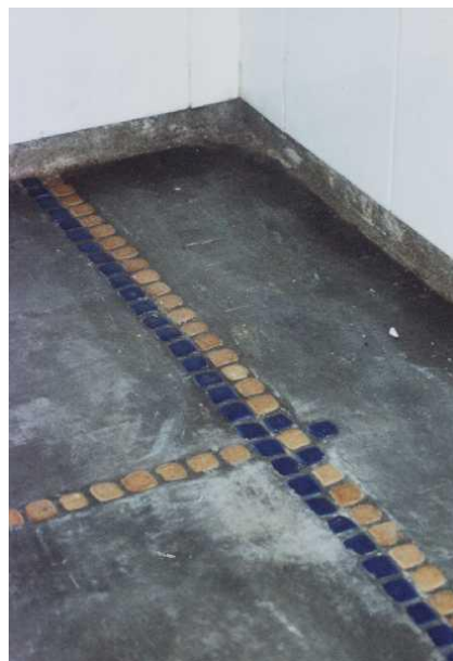
F_32 | Zócalo en media caña de portland lustrado en pisos de alisado de arena y portland y en portland lustrado
